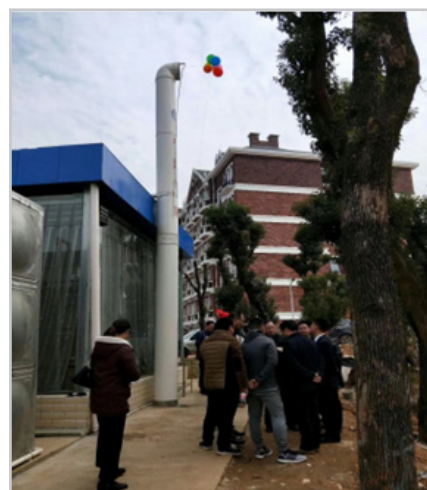
处理大学1600学生的生活垃圾,产生冷热空调给学生宿舍供暖及生活热水,冷排放,本项目排放二氧化碳排放(项目太小没作回收)。
